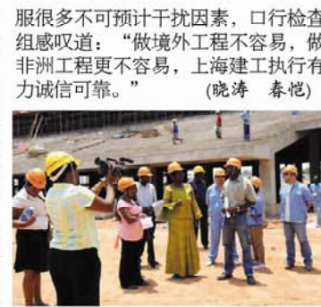
赞比亚工程部常秘和媒体参观在建的卢萨卡体育场
