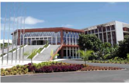
萨摩亚政府综合办公楼项目由中国政府提供优惠贷款, 上海建工负责总承包, 是落
