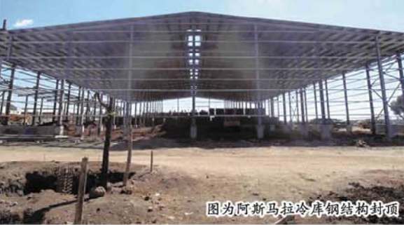
图为阿斯马拉冷库钢结构的封顶
