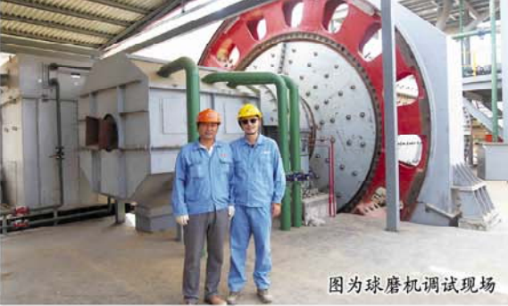
图为球磨机调试现场
