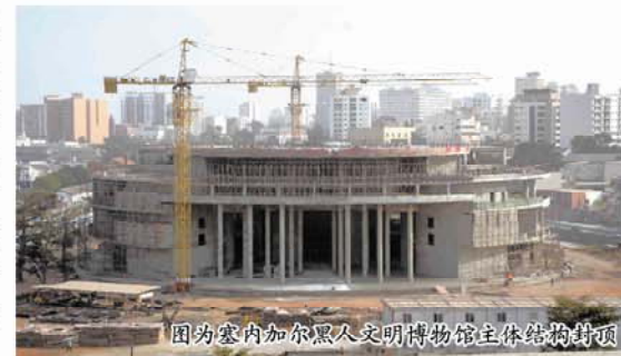
图为塞内加尔黑人文明博物馆主体结构封顶
