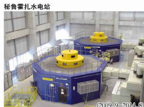
秘鲁霍拉水电站 (2009.9—2014.8)
