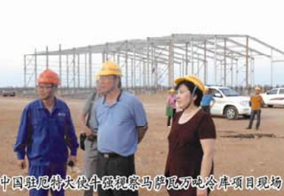
中国驻厄使领馆使领馆视察马萨瓦地冷库项目现场
