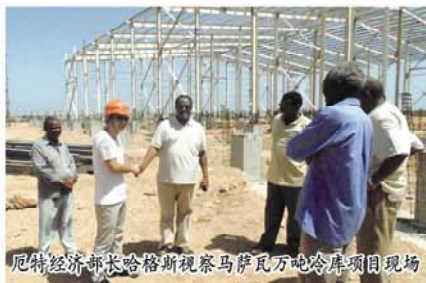
厄特经济部长哈格斯视察马萨瓦地冷库项目现场
