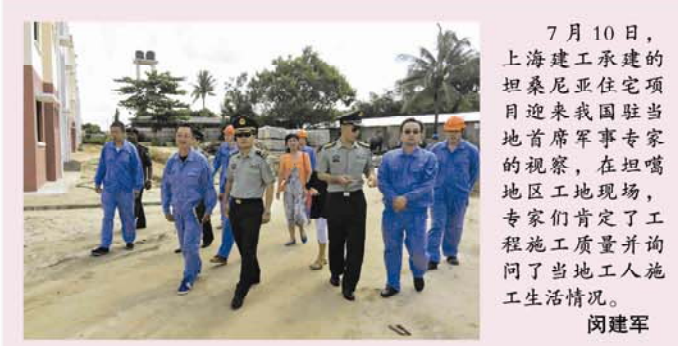
7月10日,上海建工承建的坦桑尼亚住宅项目迎来我国驻当地首席商务专家的视察,在坦噶地区工地现场,专家们肯定了工程施工进度并询问了当地施工生活情况。
