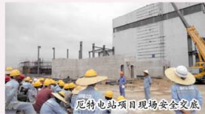
厄特电站项目现场安全交底
