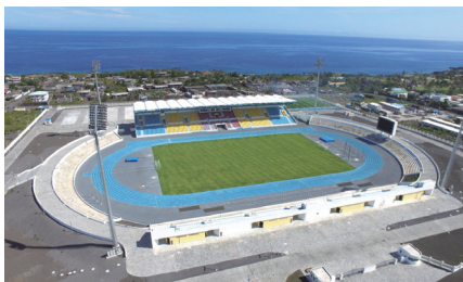
援科摩罗莫罗尼体育场顺利通过竣工验收
